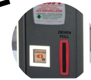
S-Bahnstation Taufkirchen, Am Bahnsteig 1 - An der Notrufsäule
